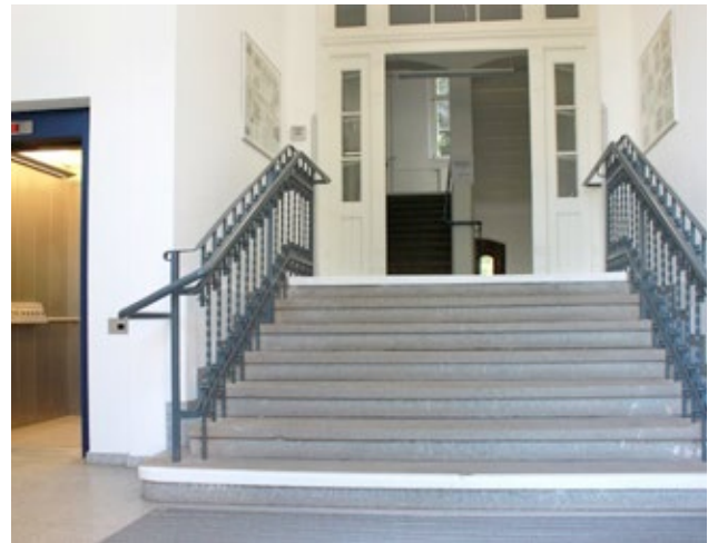
Markierung von Treppenstufen (© SFZ)
